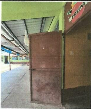
Foto 5: Cambio de puerta de aula
