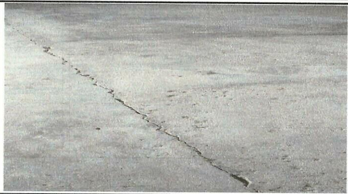
Foto 2: Mejoramiento de piso
