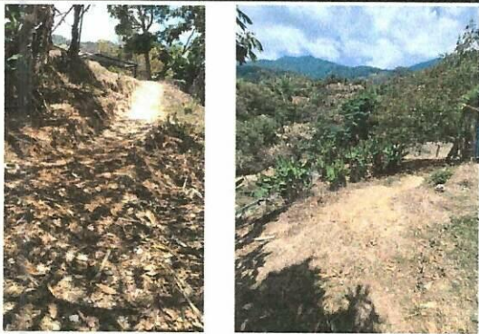
Foto1: Mejoramiento de ingreso principal del plantel estudiantil (gradas y piso)
