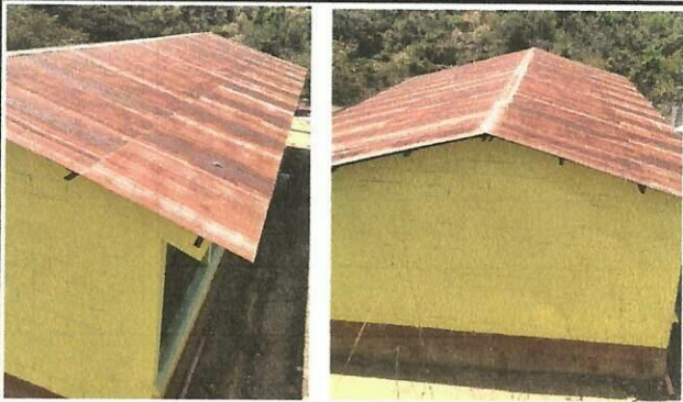
Foto 4: Mejoramiento de techo de aula
