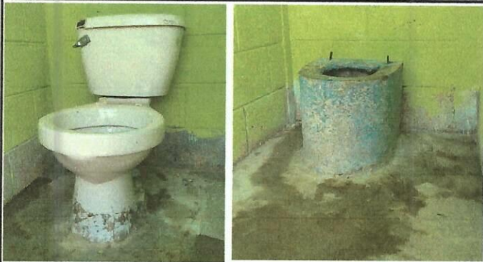
Foto 3: Instalación de servicios sanitarios con instalación de drenaje
